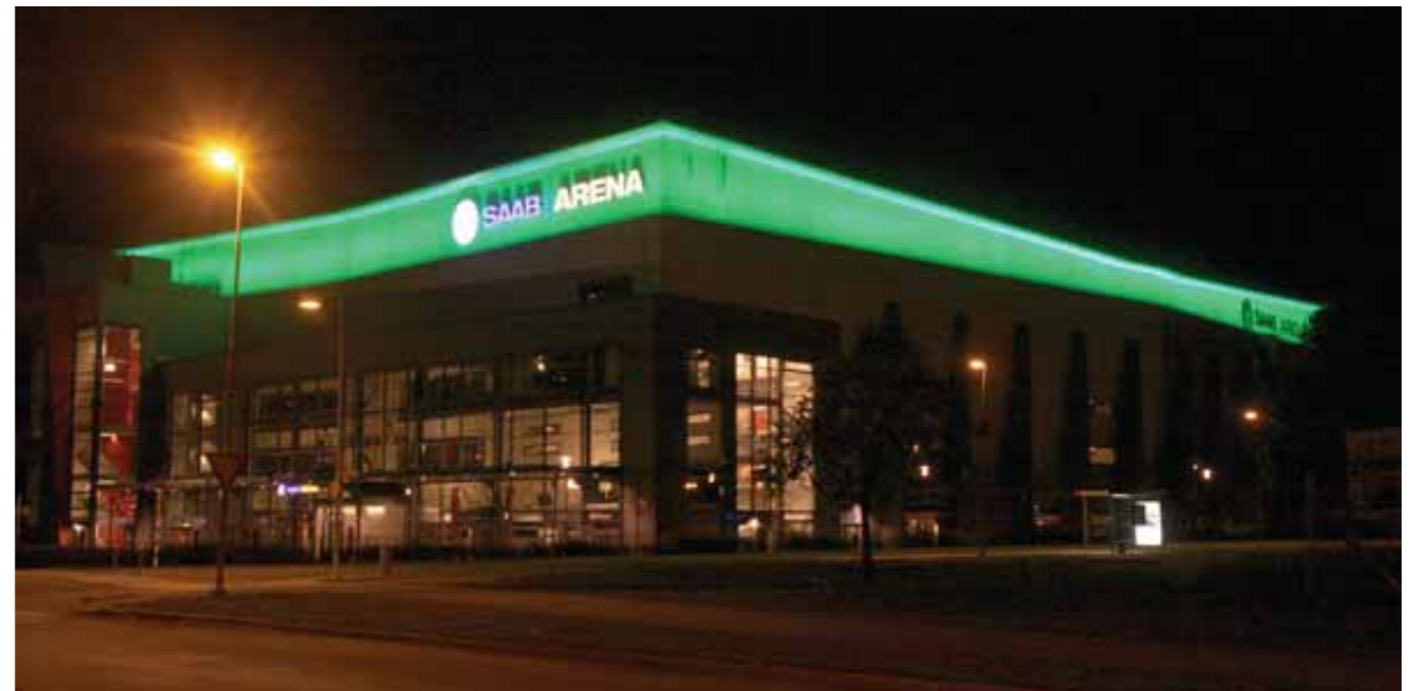
Saab Arena - Linkoping, Svezia
